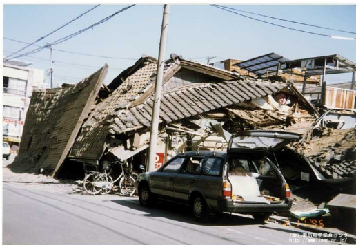
写真1 倒壊した家屋
